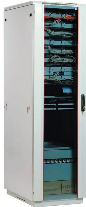
Система дистанционного управления светосигнальным оборудованием Герда-DLC предназначена для контроля и управления светосигнальным оборудованием (ССО) с автоматизированных рабочих мест (терминалов) диспетчеров посадки и руления ВС, а также резервных терминалов службы эксплуатации и обслуживания (ЭСТОП). Герда-DLC применяется на аэродромах в системах ОМИ и ОВИ.
